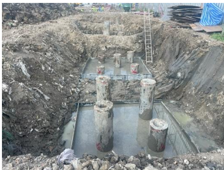
รูปที่ 27 การเจาะเสาเข็มแบบ Jack in Pile
